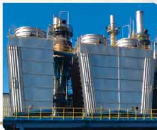
Condensador para Cozedor 800hl Usina Rio Pardo - Cerqueira Cesar/SP
